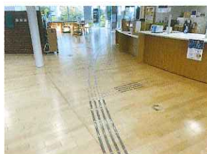
屋内の低突起の誘導用点字タイル
